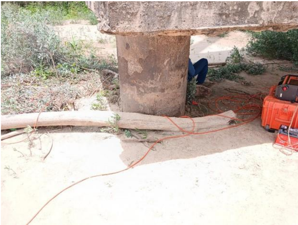
Foto 8: Se observa el pilote oriental de la Torre N°6, donde se ubicó el centro de la tomografía con el equipo. Se observa que la camisa del pilote presenta corrosión.
